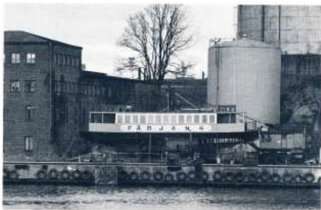
FARJAN 4 på Eriksberg 1981. Dåliga bordläggningsplåtar i för- och akterskepp är borttagna för målning av nya plåtar. Bakom färjan syns Götaverkens sista kvarvarande ångkran. Den står numera på Industrimuseet. Foto Leif Magnusson.
