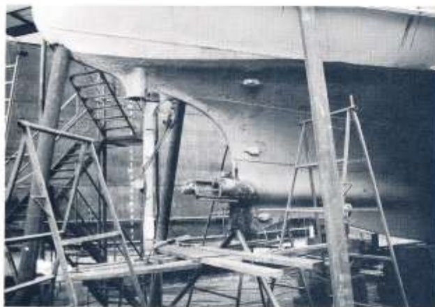
BOHUSLÄNs akterskepp med roder, propeller, propelleraxel och skådda demonterat. Sedan bilden togs har plåtarna på vardera sidan av hylsröret demonterats. Foto Gunnar Söderberg 25/11 1990.
