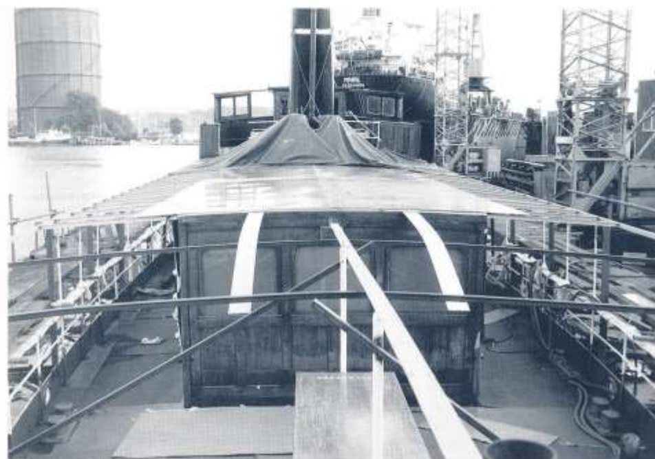
s/s "Bohuslän" hos Gotenius Varv. Fotot visar med all önskvärd tydlighet arbetets omfattning. Foto 15/9 1991 av Gunnar Söderberg.
