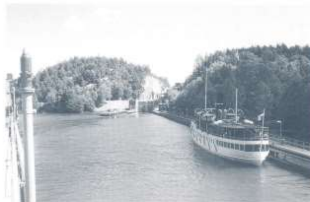
BOHUSLÄN vid Trollhättans slussar. Foto: Torsten Axberg 1996.
