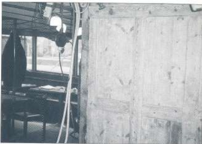
Efter rivningen av det gamla pentryt på akterdäck framstår skottet mot trappan till övre däck i sin färgna glans sedan all gammal färg bränts och skrapats bort. Det försvinner emellertid snart bakom den nya inredningen. Foto Charles de Serres
