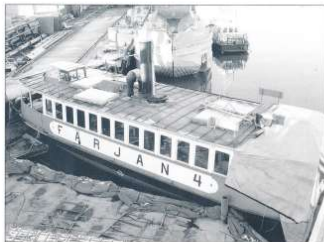
Färjan 4 vid Gotenius Varv på Ringön. Fördäcket är intäckt för att skydda pågående däckarbeten. Foto Åke Karlsson 20 november 2004
