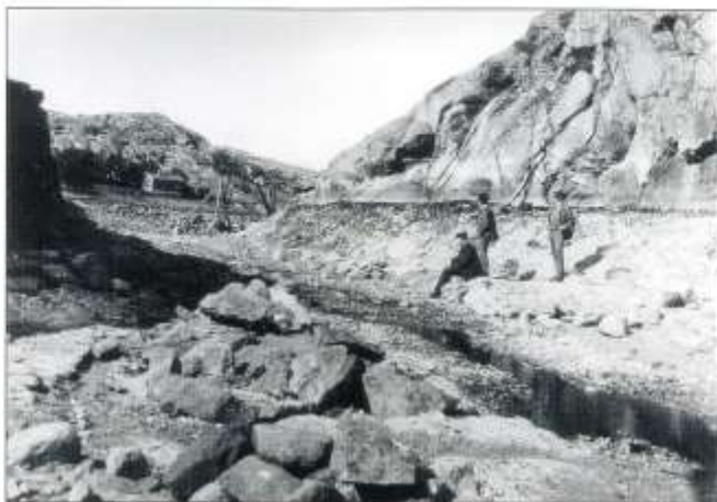
1905 påbörjades en utvidgning och förbättring av Albrektsunds kanal som avslutades 1909. Därmed blev djupet i kanalen fyra meter. Här är kanalen torrlagd under arbetet med kanalen. Foto i Ångbåtens arkiv
