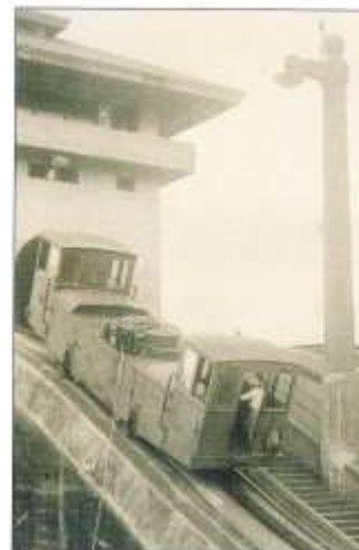
En ASEA-mula bromsar Josefina Thordéns på väg ned i en slustrappa. På bilden skymtar man även rälsen vid parallellslussen och vatturspjåret i mitten.
