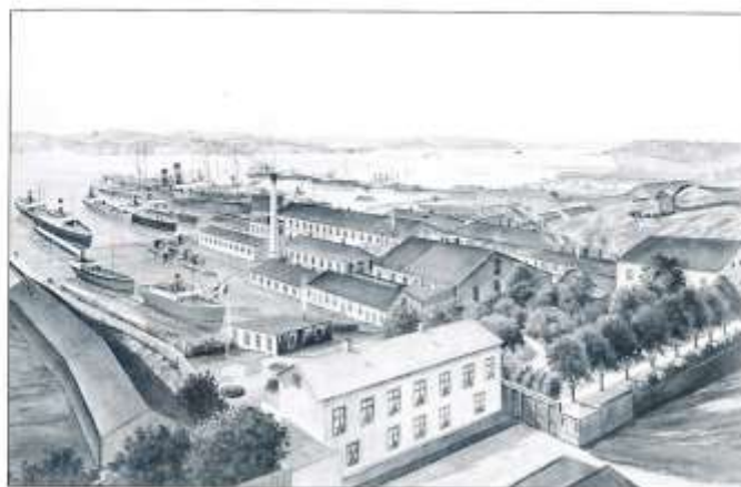
Eriksbergs Mekaniska verkstad år 1903. Till vänster slipen med torrsatta båtar, till höger om bildens mitt stapelbalden med ett skrov under byggnad. Till höger den ursprungliga verkstaden nedanför berget där huvudkontoret senare byggdes. Bild från varvets minneskrift 1953
