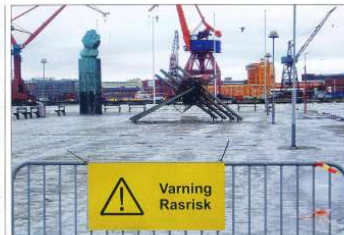
Stenpiren stängdes av efter sättningar som uppstod efter vinterns stormar och höga vattenstånd. Ålvstranden Utveckling lovar att BOHUSLAN kan ligga vid Stenpiren i sommar. Foto Ingvar Kronhamn 19 februari 2012
