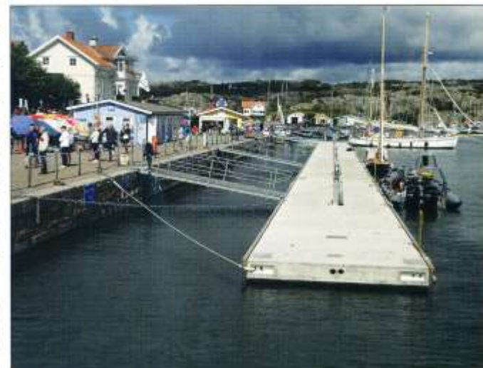
Sedan 2012 har stenkajen blockerats av en flytbrygga som förhindrar större fartyg att anlöpa Marstrandsön. 1870 började Marstrandbolagets ångare anlöpa kajen. 1999 byggdes den lilla träbryggan vid färjeläget som nu är enda tilläggplatsen för ångaren BOHUSLÄN. Foto Ingvar Kronhamn
