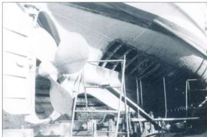
Plåtbyte hos Roos & Hagström i april 1975. Plåten i C-stråket berörde aktersalongen och de två framförliggande hytterna på styrbords sida.
