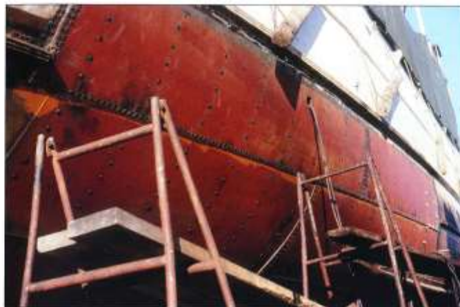
Här är de nya plåtarna på plats styrbord akter den 10 februari 1979. Plåtarna är nitade på spant och växlar utom i anslutning till befästa plåtar. I det övre E-stråket ska fönsterventiler sättas in.
