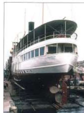
Donsö den 25 oktober 1980. Några tillfälliga fönsterventiler i akterhytter byts till rätt modell lika överig.
