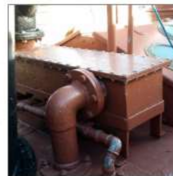
Övre bilden: "Ångfällan" i ångskorstens nederkant, en stor låda utformad som en labyrint.
