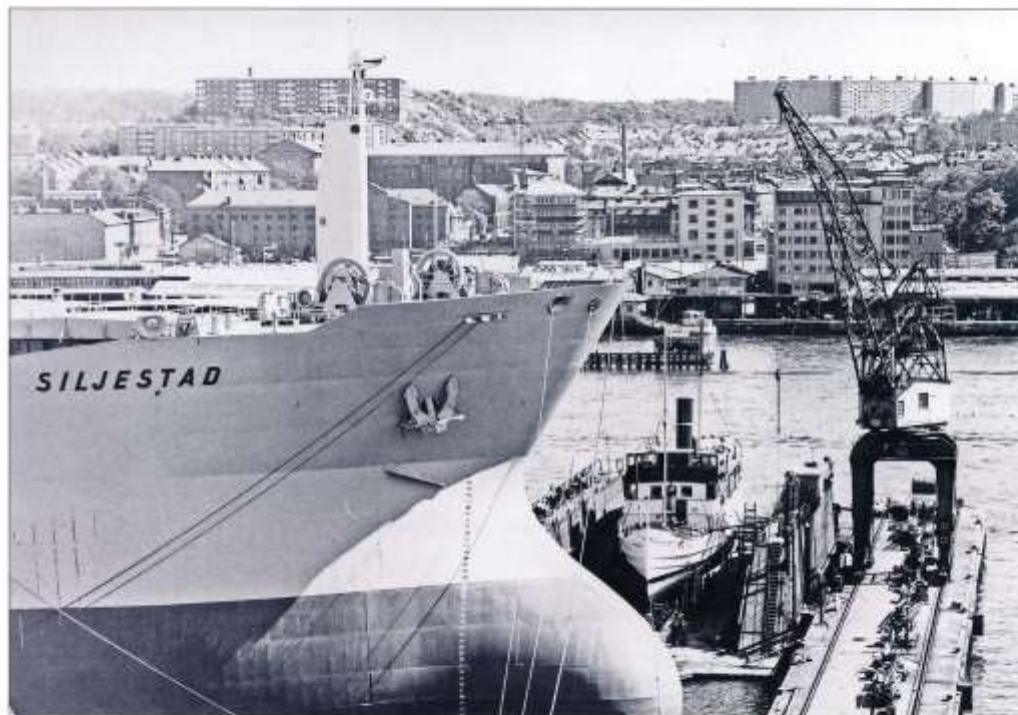
Nybygge 636 SILJESTAD och nybygge 166 BOHUSLÄN vid Eriksbergs varv 1970. Fotot ingår i Bertil Söderbergs Eriksbergssamling .
